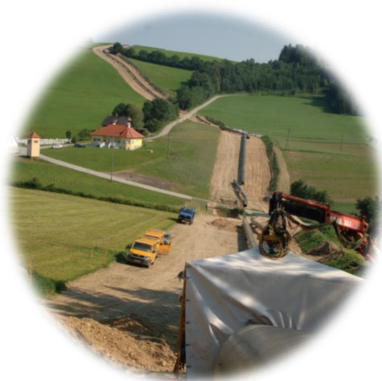
Pe durata lucrărilor de construcție.
