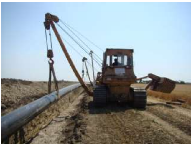
Figura 4. Poziționare unei secțiuni de conductă în șanț
