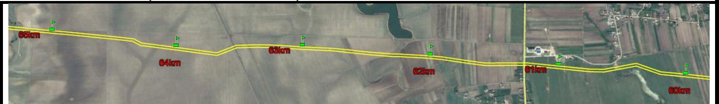
Tronson T13 BRUA: 60+000 – 65+000
