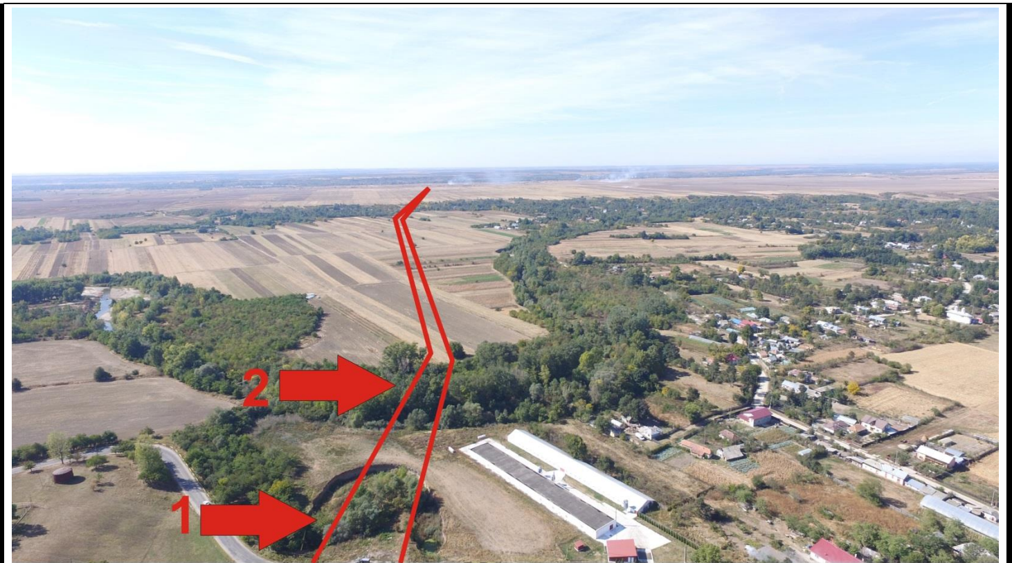
T16 Traseul din zona km 75-76. Se observă zona de râpă ocupată de vegetație arbustivă (1) și zona de traversare a râului Cotmeana (2)
