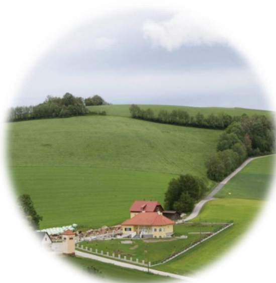
După lucrările de construcție.
