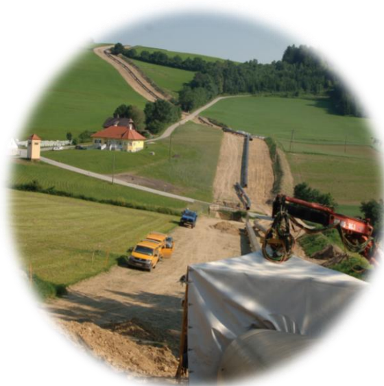
Pe durata lucrărilor de construcție.
