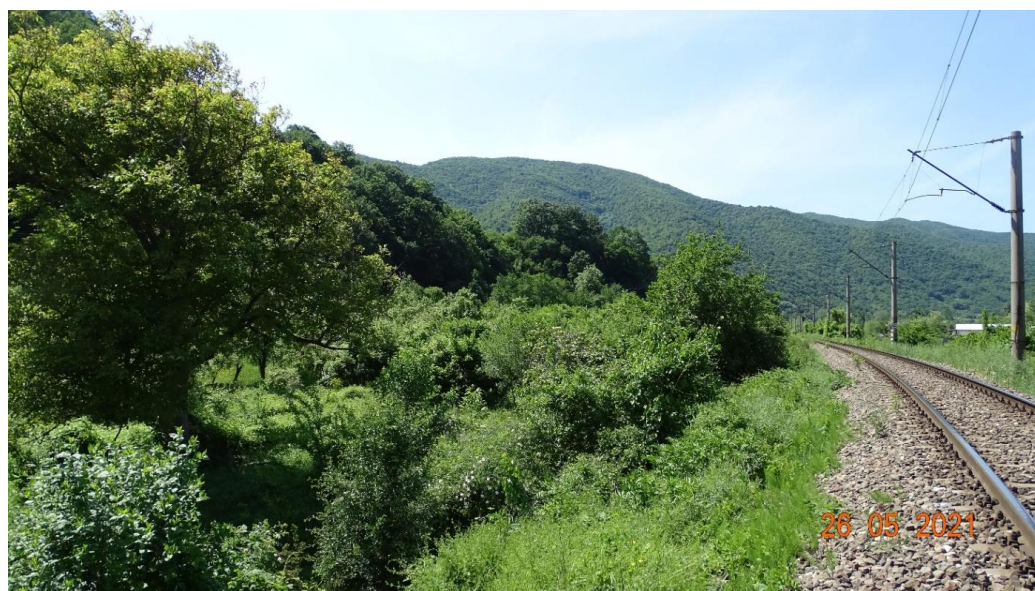
Figura 2.5-18 Aspect al amplasamentului traversat prin foraj orizontal
