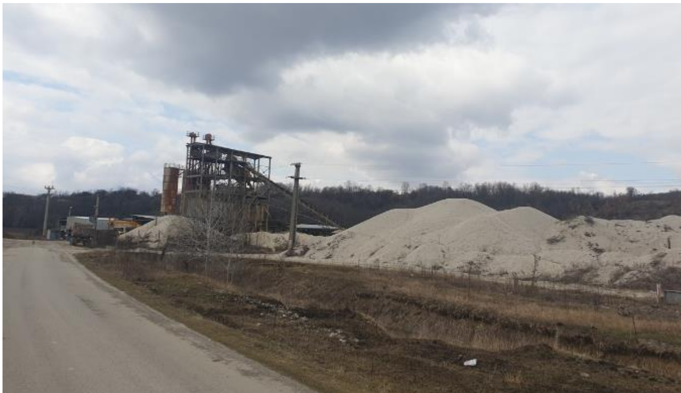
Figura 6.2.-1 Balastiera din zona km 21 al proiectului (100 m departare fata de culoarul de lucru)
