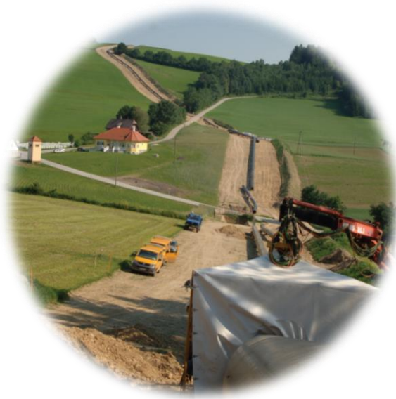
Pe durata lucrărilor de construcție.
